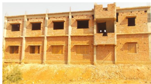
Schulhaus mit Innenausbau 1. Stock April 2015
