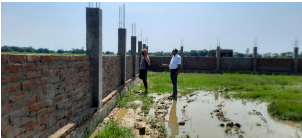
Aussenwände des neuen Therapiezentrums im Bau
