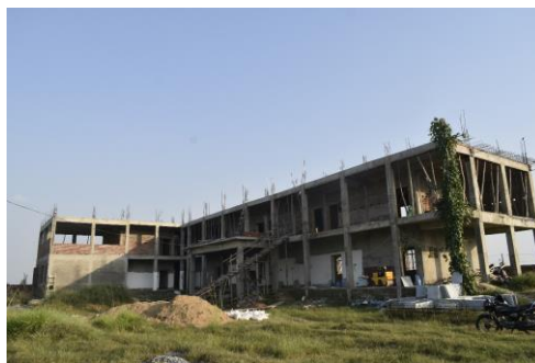
Baustelle August 2023; Rohbau 2 Etagen
